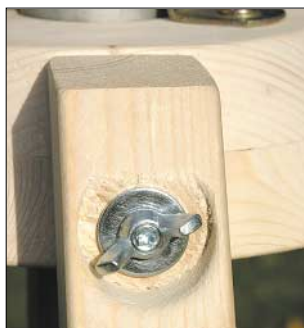
Bild 3: Ein Holzfräser oder ein Schnitzmesser schneiden die Vertiefungen für Unterlegscheibe und Flügelmutter.
